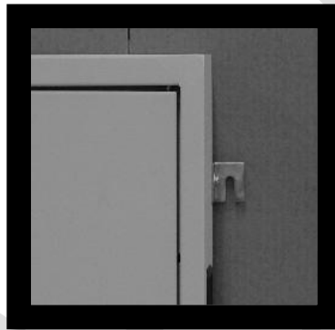
شکل 3. اتصالات تابلو فرمان
